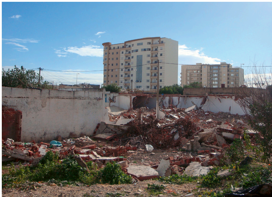
Figure 5.2 Destruction d'une partie des habitations à Zouaidia (Tunis)
